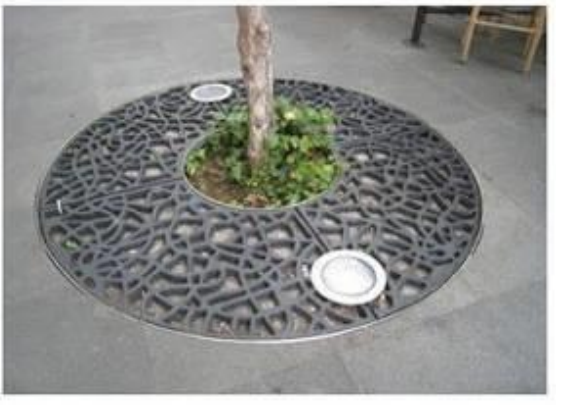
Hình 33-7 Tham khảo kết cấu hố trồng cây bằng kim loại ở Singapore
